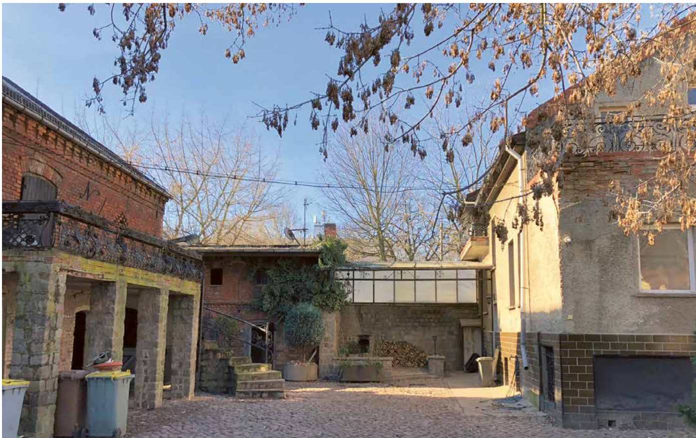
Geschafft! Das 3.800 qm große Areal einschließlich der Gebäude ist nun vollständig beräumt. Hier ein Blick vom Hof auf das Wohnhaus (rechts) und die Scheune (links).
